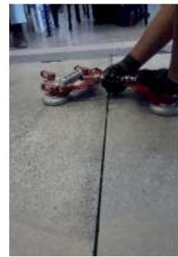
3. Colocar la siguiente placa, posicionar con las juntas recomendadas.
