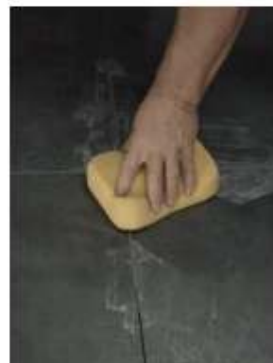
3. Remove el material excedente.
