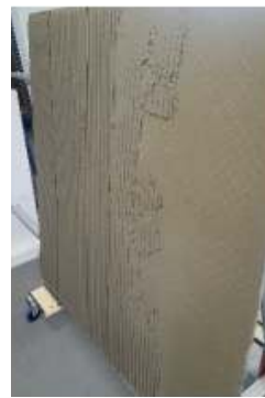
3. Aplicar el adhesivo sobre el sustrato, siempre en el menor sentido.
