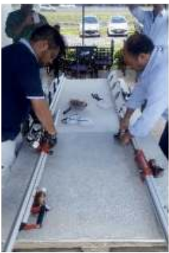
1. Manipular la placa con ventosas para una mejor comodidad.
