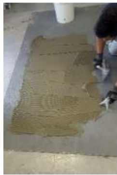
2. Aplicar el adhesivo sobre el sustrato, siempre en el menor sentido.
