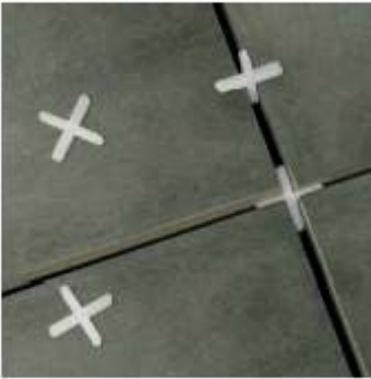
| Separadores entre placas, separación mínima 3mm
