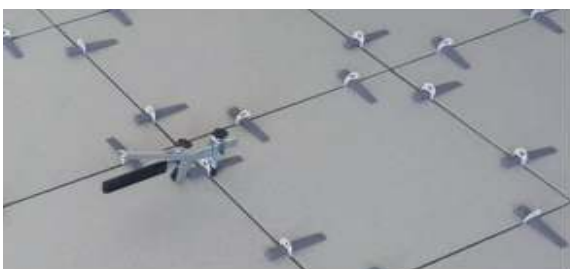
| Aplicación de niveladores y separadores con arco y cuña.
