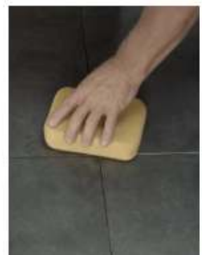
4. Limpiar hasta remover todos los restos.
