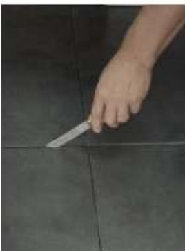
1. Limpiar las juntas de materiales no deseados.
